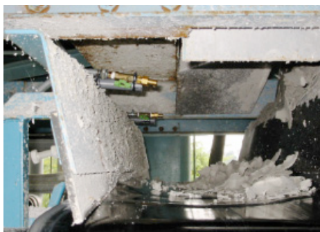
■脱水ケーキコンベアに散布
